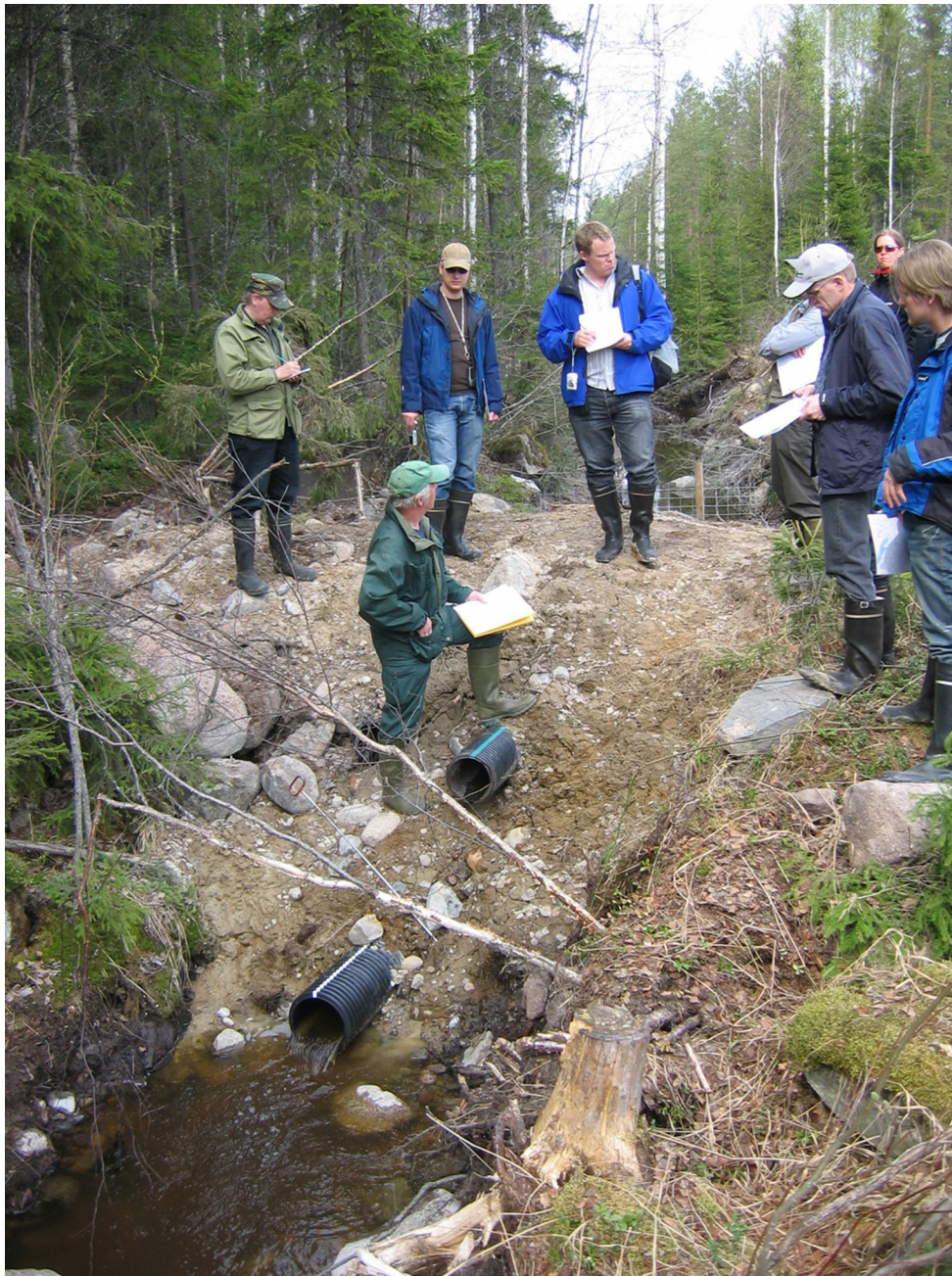
Fig. 2 Peak runoff control dam. Photo: Hannu Hökkä
