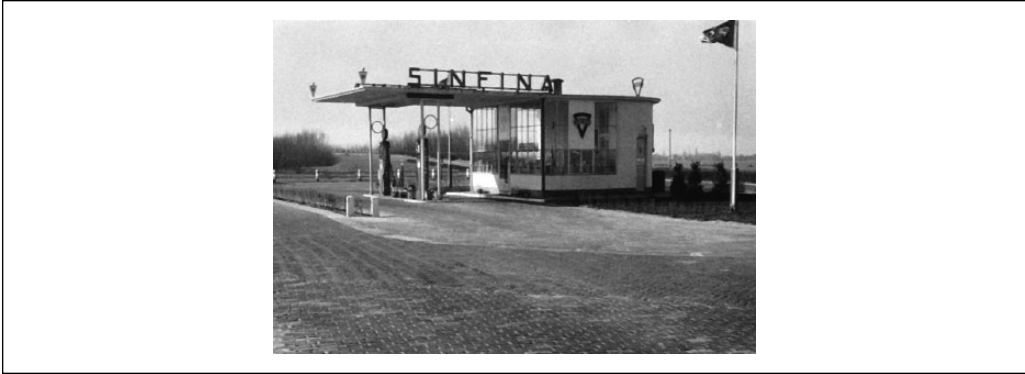
Figure 32. Sinfina gas station by the Dutch architect Sybold van Ravesteyn in Alphen aan den Rijn. Source: Collectie Rijksdienst voor het Cultureel Erfgoed, objectnummer 900.838.
